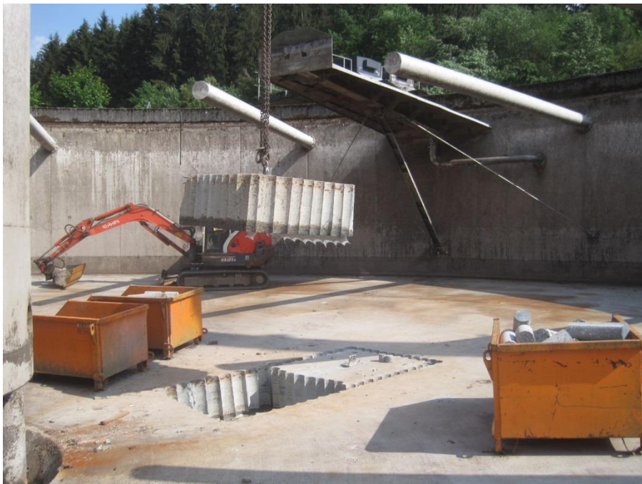
Die ausgestanzten Betonteile wurden mithilfe eines Krans aus dem Becken gehoben, um an die darunter verlaufende Leitung zu gelangen.
