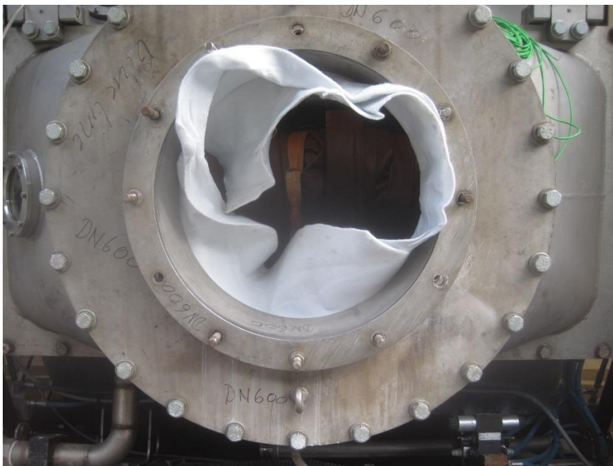
In die weniger stark korrodierten Leitungsstücke wurde ein Nadelfilz-Inliner eingezogen, der im ausgehärteten Zustand so fest ist wie glasfaser-verstärkter Kunststoff.
