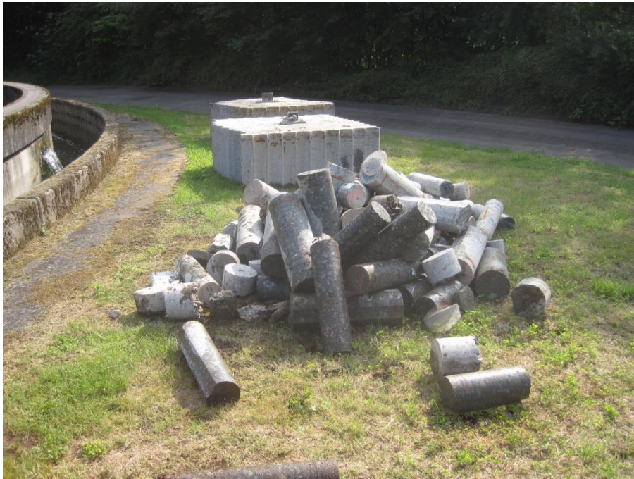
Die 75 Zentimeter starke Bodenplatte des Nachklärbeckens musste mit Kernbohrungen ausgestanzt werden.
