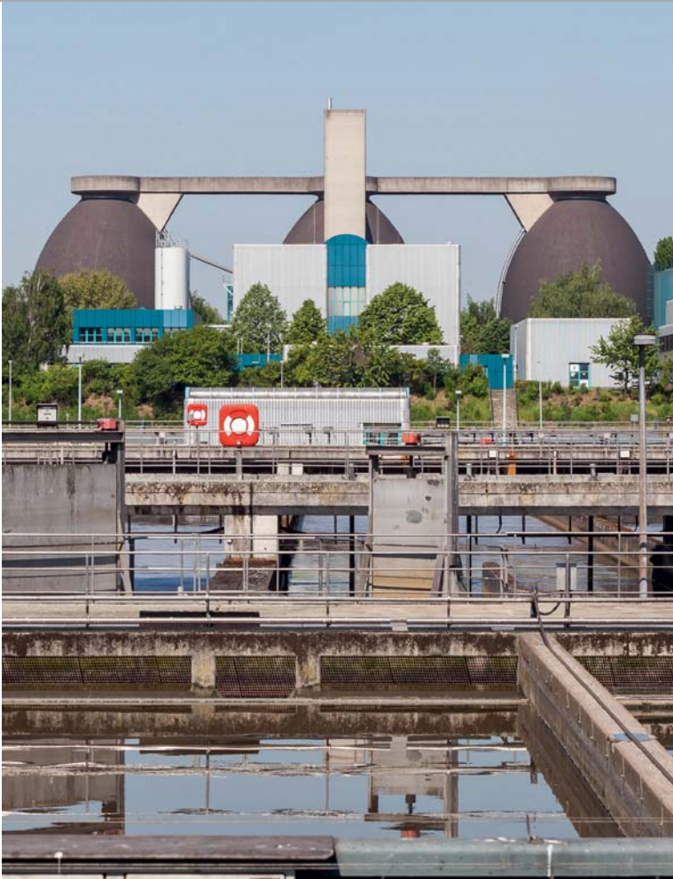
Biologische Reinigungsstufe (vorn) und Faultürme
