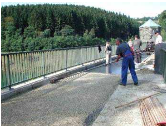
Asphaltarbeiten auf der Mauerkrone
