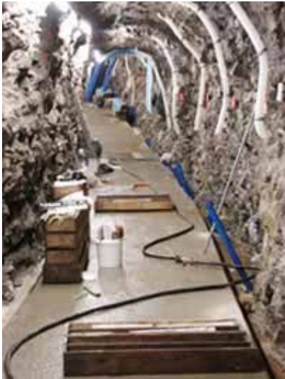
Kontrollgang Sohlwasserdruckmessstelle
