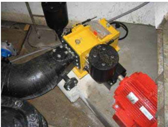
Wasserkraftanlage im rechten Schieberhaus
