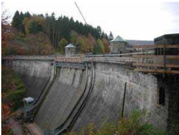
Fürwiggetalsperre während der Sanierung im November 2006
