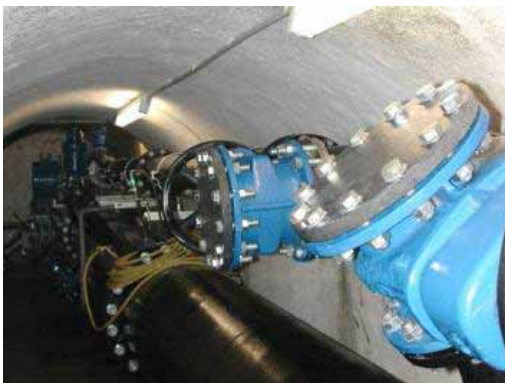
Grundablass-und Rohwasserleitung
