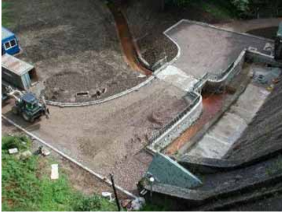
Umbau am Tosbecken mit neuer Brücke
