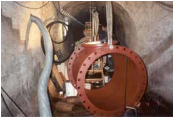
Grundablasssanierung
