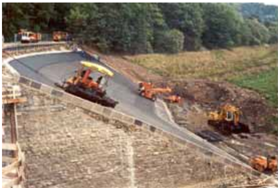
Vordamm Amecke während der Sanierung
