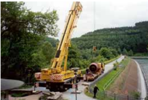
Das alte Ringkolbenventil des rechten Grundablasses wird auf das Schaustückfundament gehoben.
