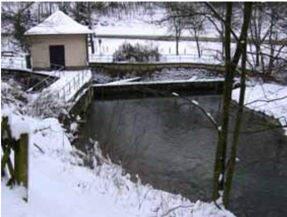
Fassungsbauwerk Brabecke im Januar 2005
