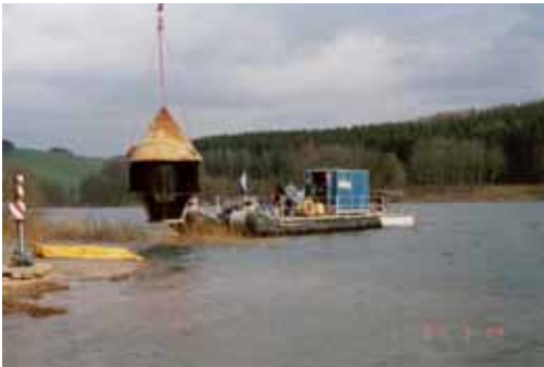
Übernahme des Einlaufrechens vom Taucherponton mit dem Kran
