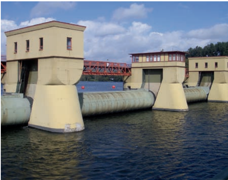
Bild 1: Ansicht des Walzenwehres am Hengsteysee von der Unterwasser-Seite
