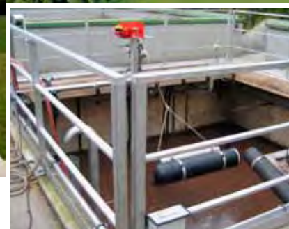
Schlammwasserbehandlung im Nebenstrom durch Deammonifikation
